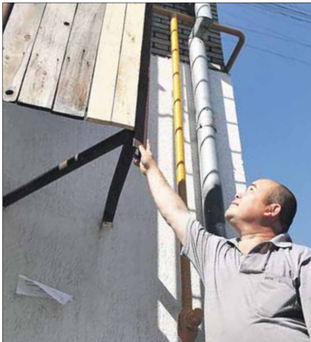
Осмотр пожарной лестницы в доме 19а на улице Гончарова
