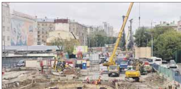
Стройплощадка «Метростроя» на Огородном проезде
