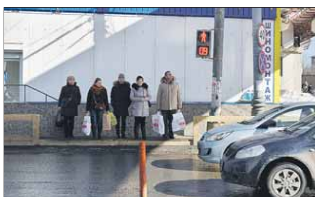
На ул. Милашенкова, 1, ведутся работы по восстановлению регулируемого пешеходного перехода
