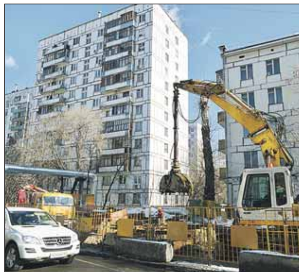
У дома 30 по улице Яблочкова ведётся реконструкция теплосети
