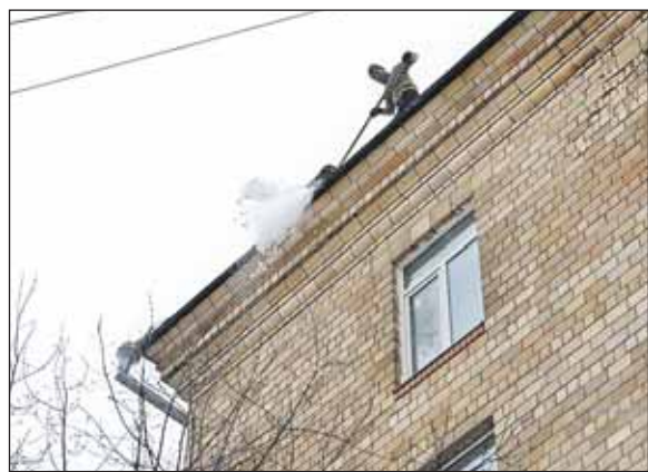
В СВАО очищают кровли от снега 1430 человек
